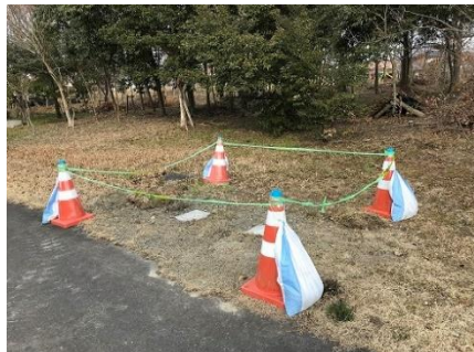
工事中立入禁止
